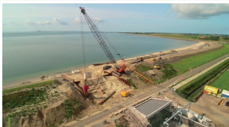
Zomer 2018: De bouw van het gemaal De Schans vordert. Het pomphuis en de uitstroomboker zijn gereed, de damwanden worden verwijderd.
