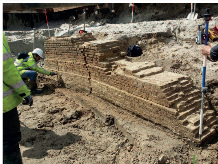
De dikke oostelijke muur van de wachttoren wordt opgegraven. In het midden van de muur zit een grote scheur.
